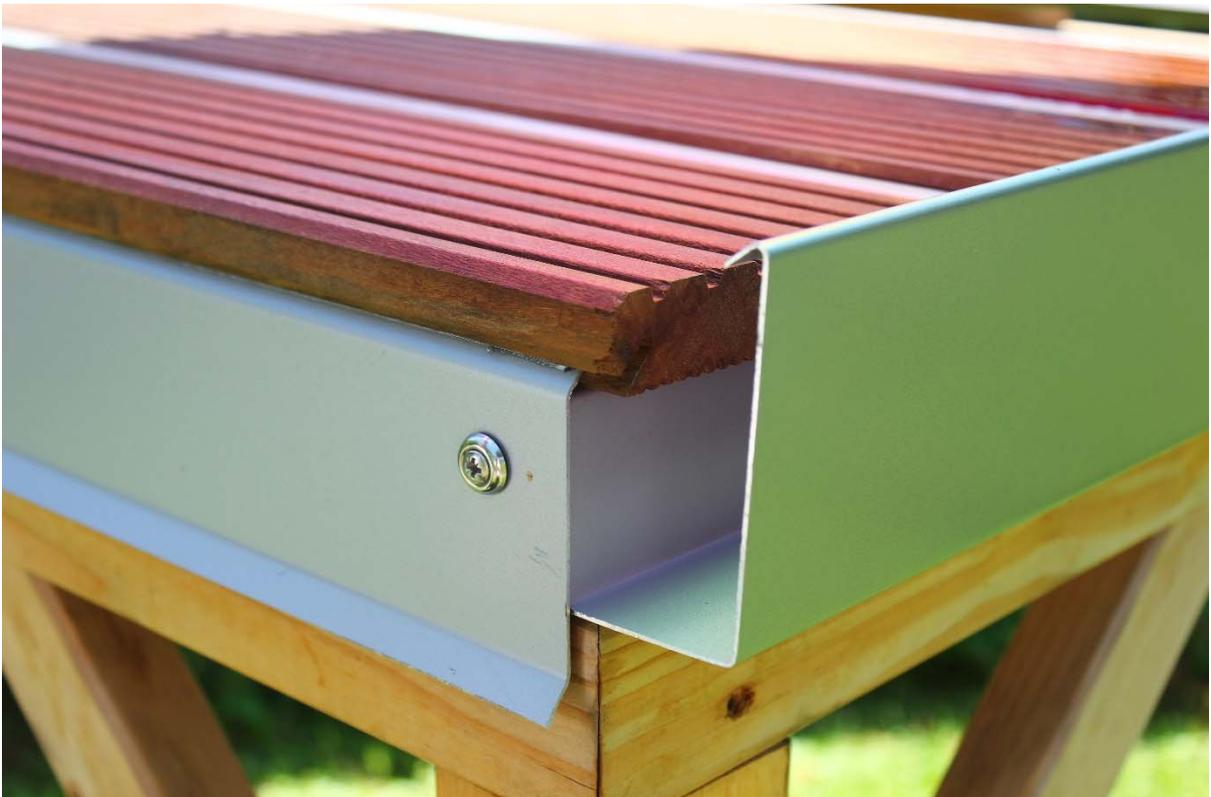
BILD 5 und BILD 6 Regenrinnen Anschluss mit KIT-Schnur zwischen Belag und gekantetem Blech, einmal ohne und einmal mit Abschlussleiste über den Enden.
