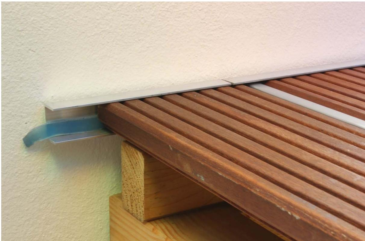
BILD 2, BILD 3 und BILD 4 Anschluss für offene Seiten-Bereiche und an die Fassade, bei Fassadenverschraubung und Bohrung, zuerst das Wärmedämmverbundsystem bzw. den Fassadenaufbau überprüfen, das Dichtungsband kann auch nur an das Blech geklebt werden.
