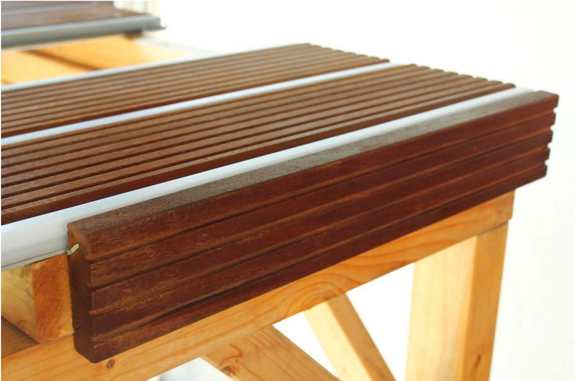
BILD 8 Montage mit richtiger Verspannung beim Vorbohren
