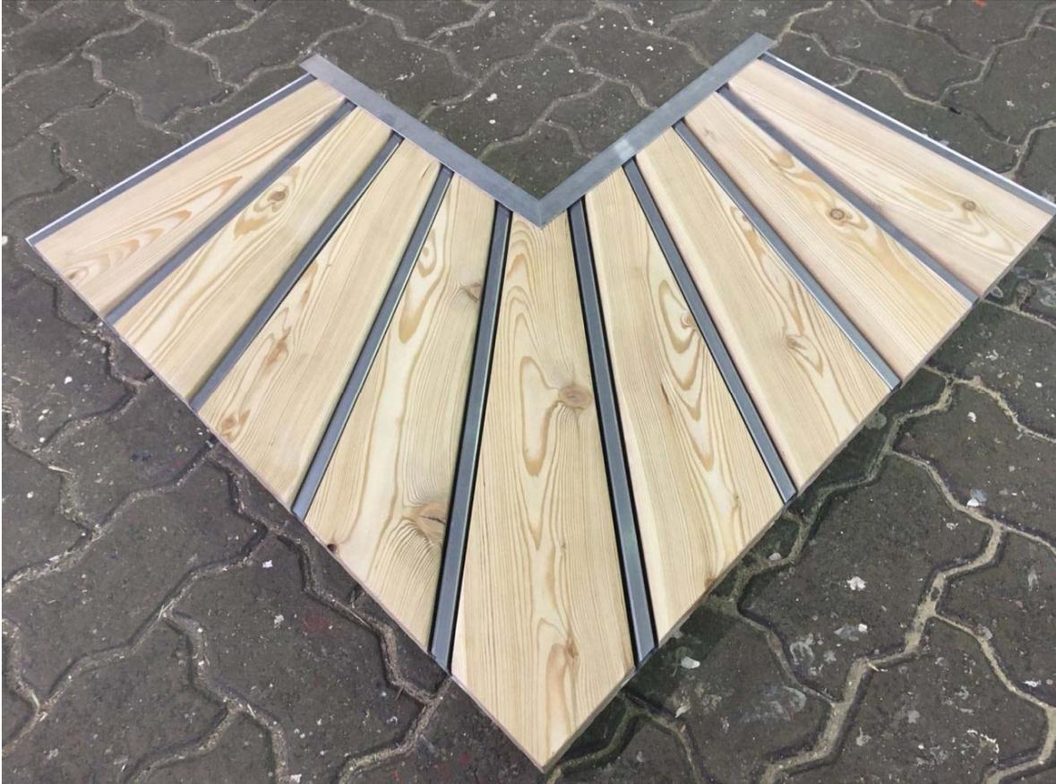
BILD 10 Belag-Richtungsänderung am Haus mit Aluminiumprofil. Note 2,0
